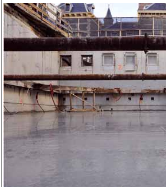
Betonnen vloer van de kelder.
