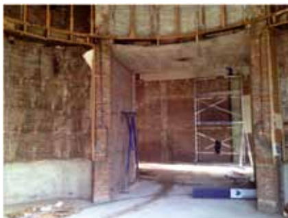
De trap vanaf de entree van Plein 26 is gesloopt.
