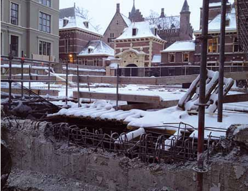
Slechts enkele zaken werden in de uitvoering doorgeschoven, zonder dat dit effect heeft gehad op het totale tijdschema. Zo moest het vlechten van betonstangen op het voormalige voorplein van het museum door de sneeuwval wat later plaatsvinden. Deze uit staal gevlochten mat is inmiddels opgeslokt door een dikke betonlaag.
