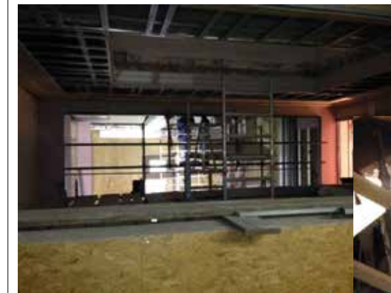
Tijdelijke tussenverdieping in Plein 26
